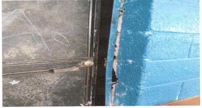
Foto 4: Modulo 2 cambio de puerta y repintar paredes
