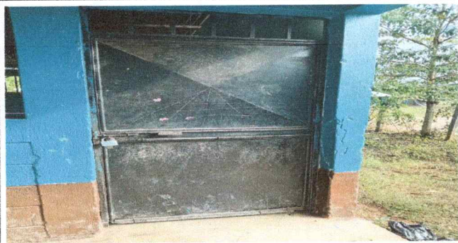
Foto 3: Modulo 2 Restablecer las pinturas de las paredes y la puerta
