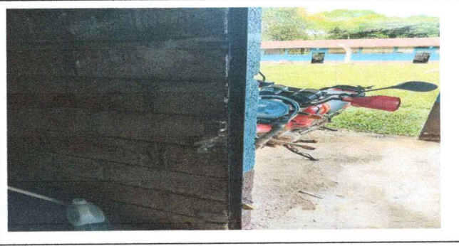
Foto 6: Modulo 2 Repintar paredes
